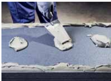
Слика 2 Уколико има разлика у нивоима или неравнина на површини, адхезиви малтер се наноси тракасто по свим ивицама задњег дела и као тачке у средишњим деловима термоизолационе плоче, мистријом, користећи методу наношења трака и тачака.
