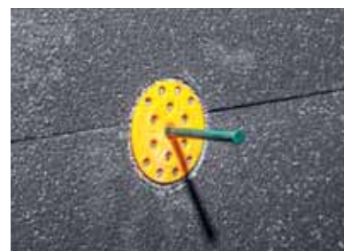
Слика 3 Урупу се стављају зидни прикључци. А типле се забијају до краја.
