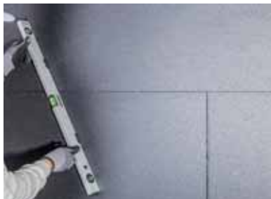
Слика 2 Нивое плоча треба проверити васервагом (либелом).
