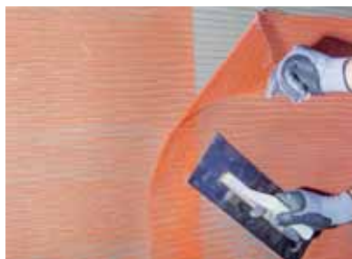
Слика 2 Мрежа од стаклених влакана треба да се нанесе на први слој површинског малтера када је још увек влажан притисањем са врха до дна и широким растезањем, без пресаивања и постављањем на једнако растојање од изолационе плоче по целој површини. У спојницама, мреже од стаклених влакана увек треба да се преклапају за 10 cm.
