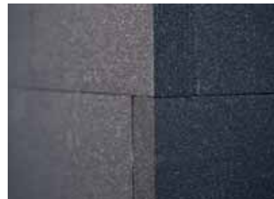
Слика 3 Термоизолационе плоче се постављају без празнина и у цик-цак стилу почев од дна зида нагоре. Плоче требају бити постављене у цик-цак стилу на угловима.
