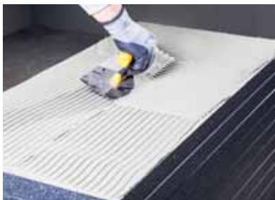
Слика 1 Ако је површина равна; адхезивни малтер се наноси на целу термоизолациону плочу мистријом или одговарајуће засеченом мистријом, користећи методу лепљења целе површине.
