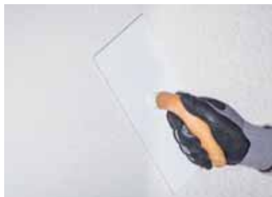
Слика 2 Пластичном мистријом се наноси преко површине да би се формирала текстура пре него се осуши.
