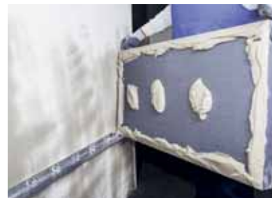
Слика 3 Приликом наношења адхезивног малтера на задњој страни изолационе плоче, пази се да се не прелије по ивицама.
