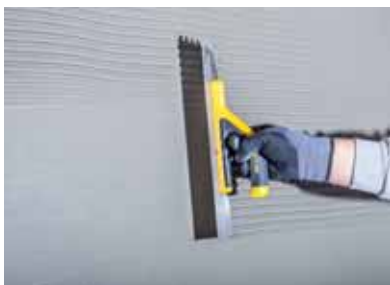
Слика 1 Након лепљења Teknosistem термоизолационих плоча и постављања зидних прикључака, наносе се два слоја површинског малтера. Припрема Teknosistem гипс малтера наноси се на суву хомогену површину челичном мистријом.
