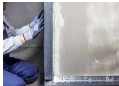
Слика 3 Димензије цокла (Socle) профила, које треба монтирати на растојању од 2-3 мм бирају се на основу дебљине термоизолационе плоче која ће се користити.
