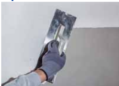
Слика 1 Teknosistem минералан декоративан малтер са текстуром на површину се наноси мистријом.
