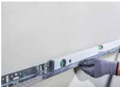
Слика 1 Празнине удубљења и исплучења између зида и Teknosistem цокла (Socle) профила коригују се помоћу типли различите дебљине, а површина се мери васервагом.
